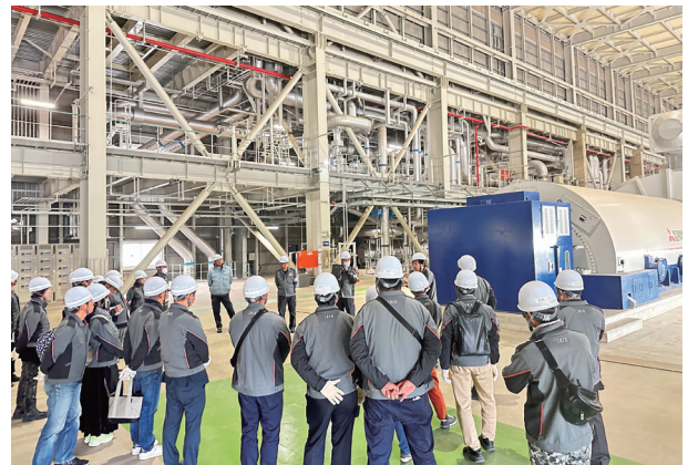
蒸気タービン
